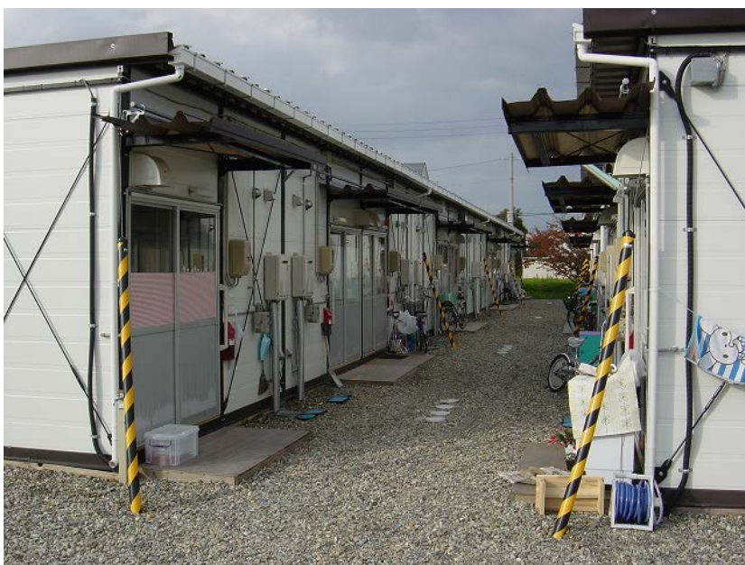
仮設住宅玄関側を南妻面から見る(給湯器、ガスメーター、電力計、排気口)
