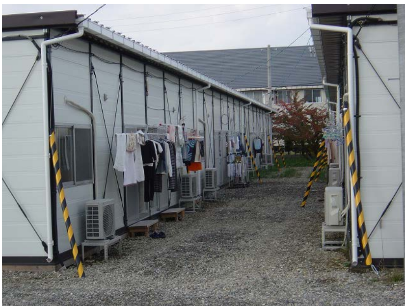
仮設住宅勝手口側(ヒートポンプ室外機)
