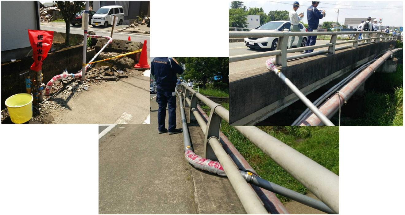
写真 4.2.3 仮設配管による応急復旧状況
