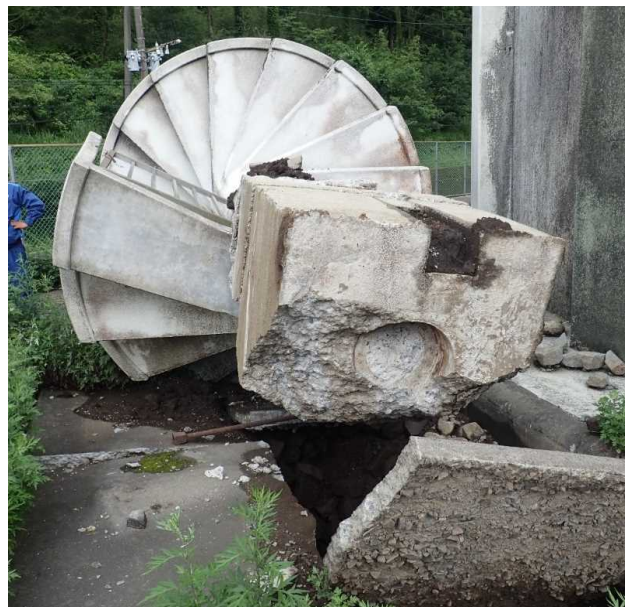
写真 6.3.1 阿蘇市の被災状況
