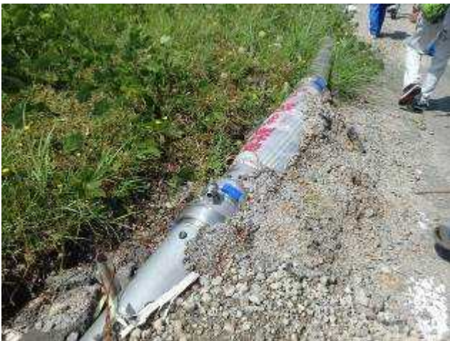
写真 6.5.2 小森減圧槽配水管の 仮設配管（リース）
