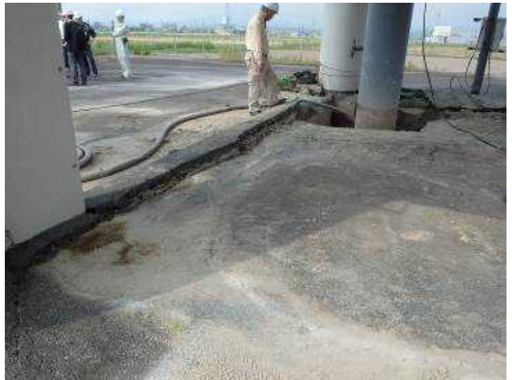
■ 秋田第 2 水源池 地盤沈下状況
