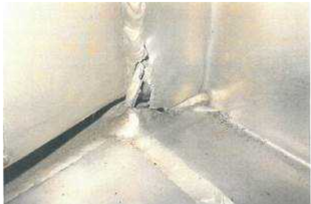
写真 6.1.3 配水施設の被災状況（舞原配水場）
