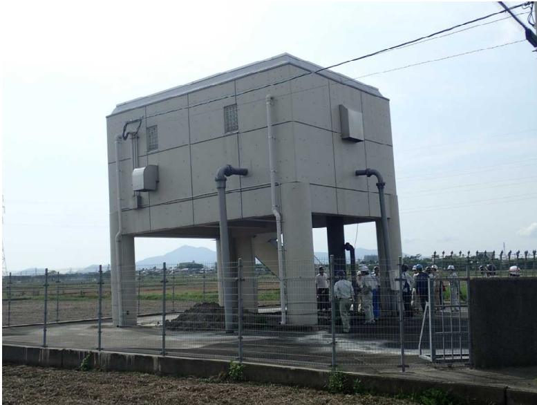
■ 秋田第 2 水源池 建屋傾斜
