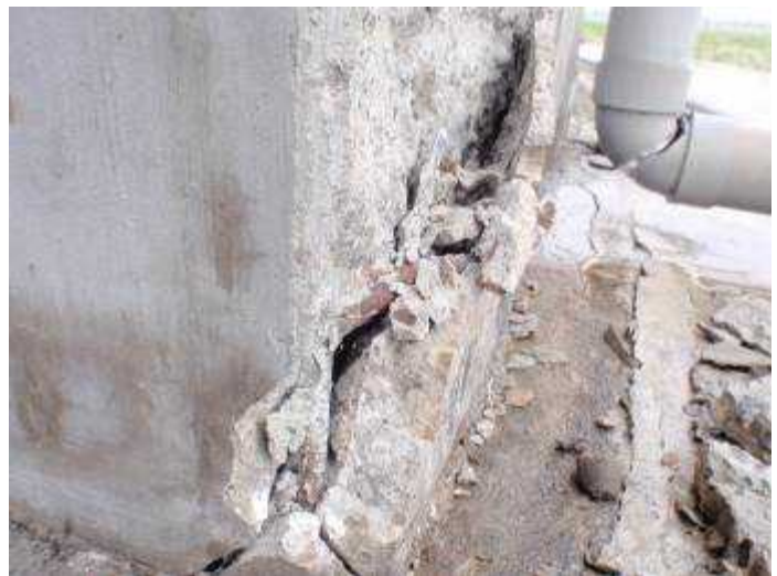
■ 沼山津調整池の損傷状況
