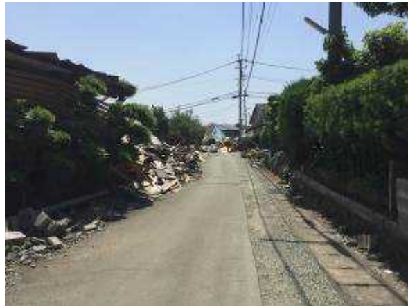
写真 6.2.1 益城町の被災状況
