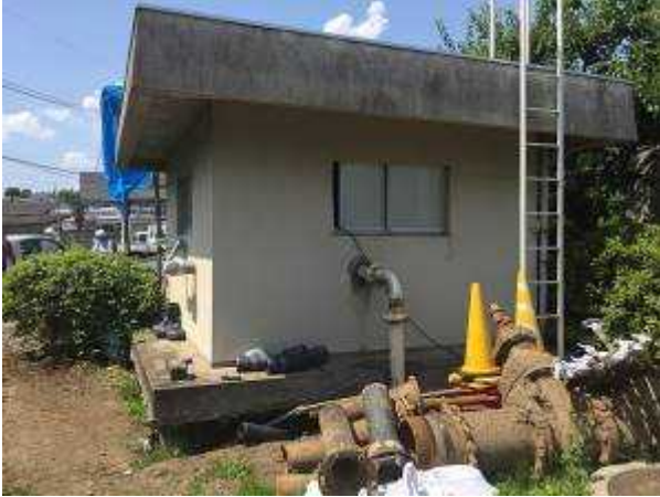
水源建屋基礎損傷
