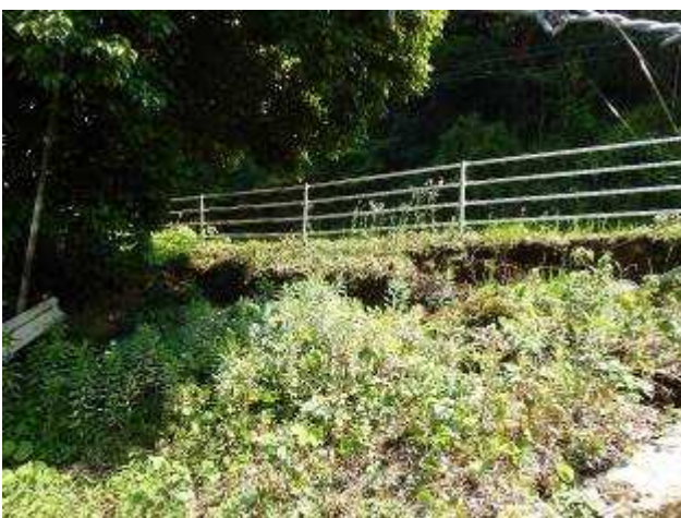
写真 6.5.4 小森減圧槽付近の 地表断層の状況
