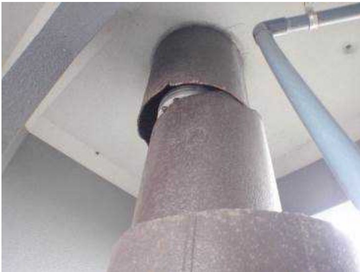
■ 沼山津 9 井のケーシングの損傷
