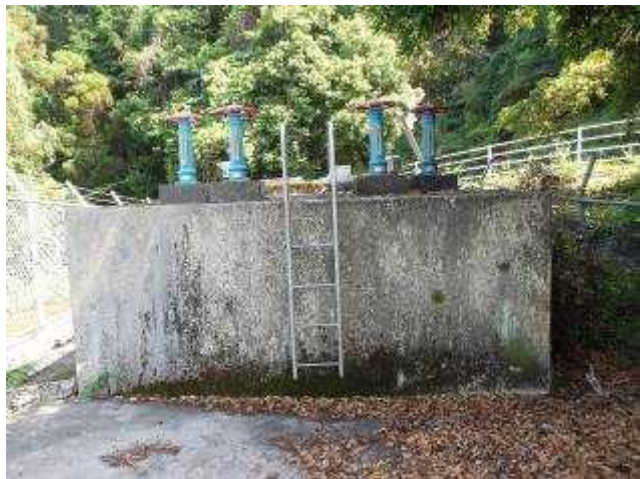
写真 6.5.3 小森減圧槽の傾斜
