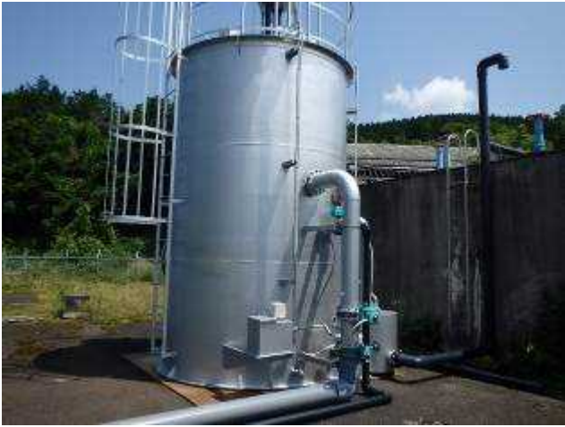
写真 6.5.1 大峯配水場 仮設急速ろ過池（レンタル）
