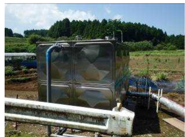
写真 6.5.5 仮設減圧水槽（小森減圧槽）
