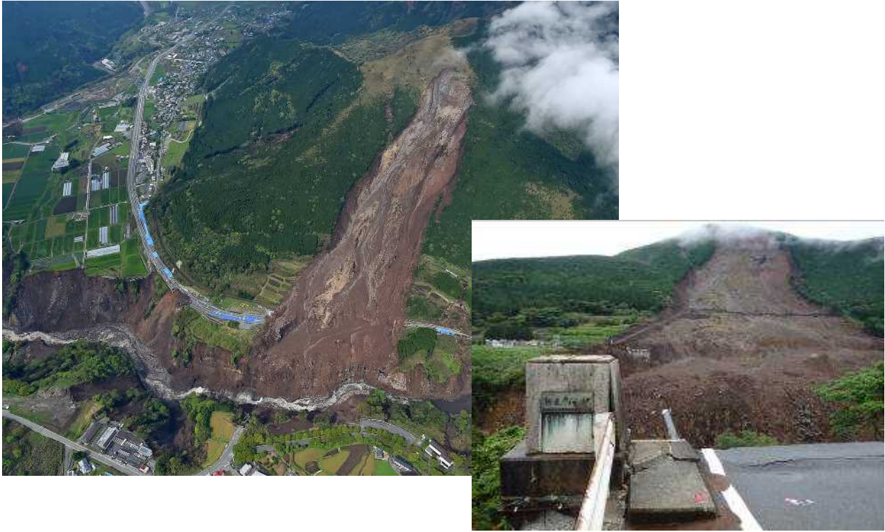
写真 6.4.1 阿蘇大橋崩落現場
