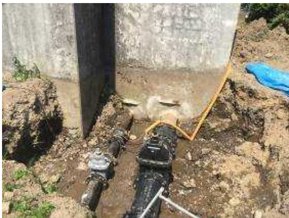
水源着水井管路接続部損傷
