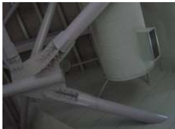
写真 11.8 屋根 壁の取合部分、吹出口
