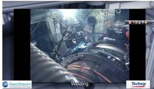
ドライチャンバー内溶接状況(人が作業)(Technip)
