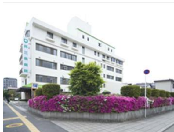
呉三条病院（旧中川脳神経外科病院）
