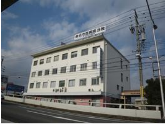
桑名市民病院分院（旧 平田循環器病院）
