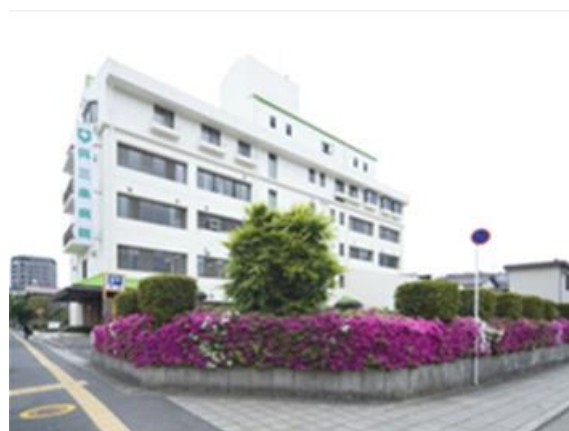
呉三条病院 (旧中川脳神経外科病院)
