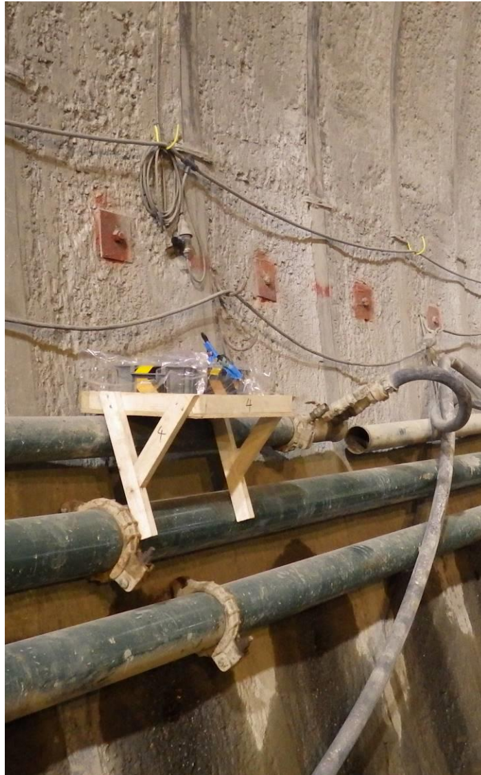
図 18 治具を使用して定点を設定した例
