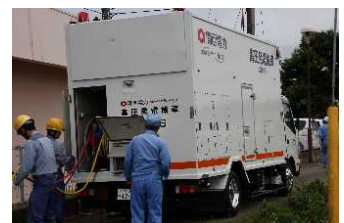
電源車の配備
