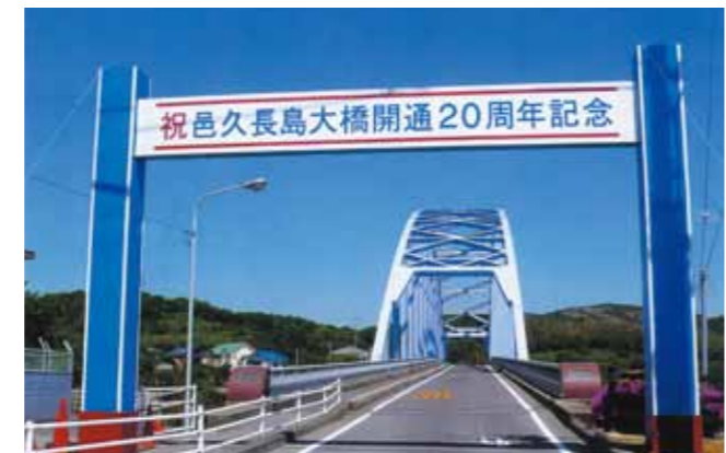
人間回復の橋と呼ばれる邑久長島大橋
