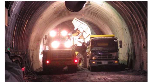
車両系機械によるずり出し作業
