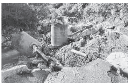
図2 2019年東日本台風による水道の被災状況(上:浄水場の冠水, 下:浄水場の取水口流出) 文献[16]を転載
