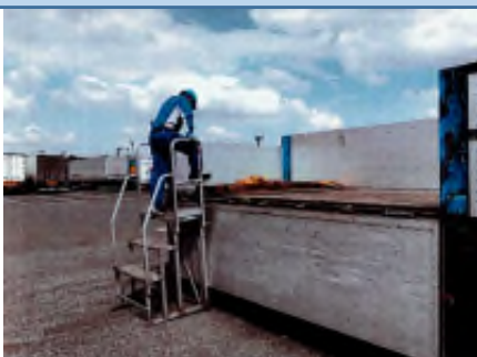
墜落・転落防止：昇降台の導入
