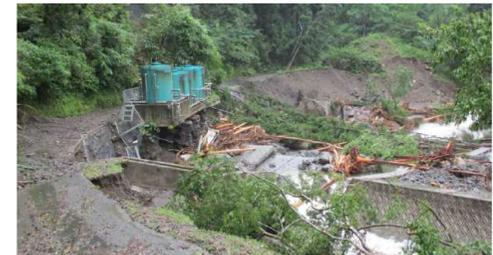
土砂崩れ等で破損した取水施設 (熊本県八代市)
