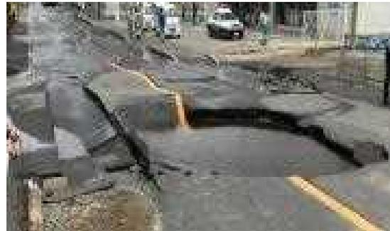
大阪府北部を震源とする地震における送水管の破損現場
