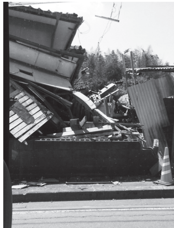
図1 熊本地震で崩壊した家屋
