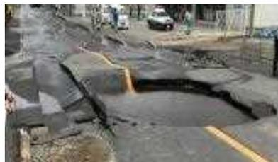
大阪府北部を震源とする地震における送水管の破損現場
