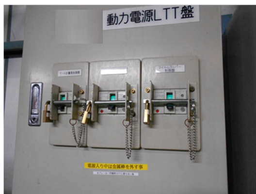
図 206 元電源の不意起動防止の事例
