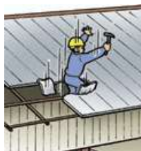
「屋根の踏み抜き・墜落」
