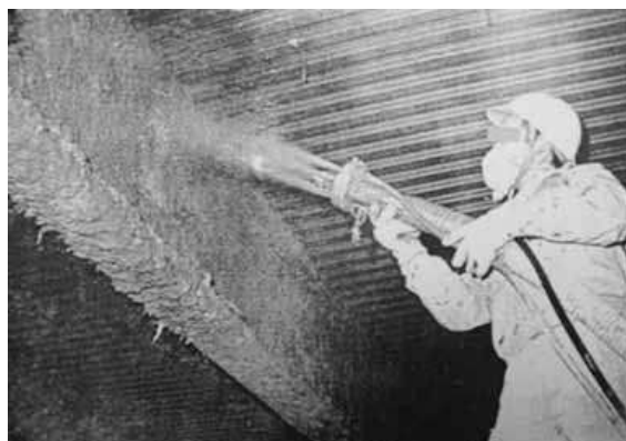
鉄骨梁への吹き付け塗装
