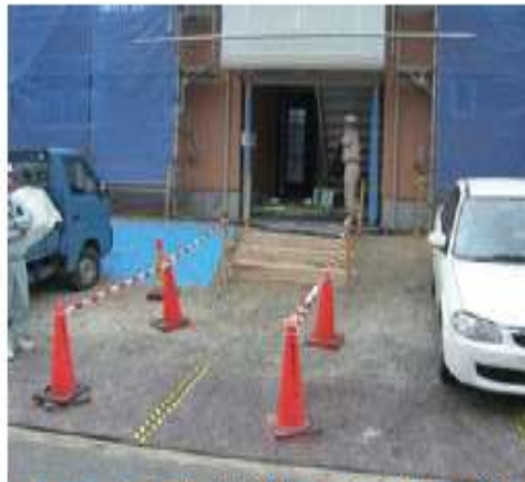
*トラテープで敷鉄板の段差も改善
