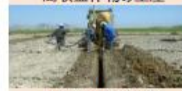
《実証ほ場の設置》
