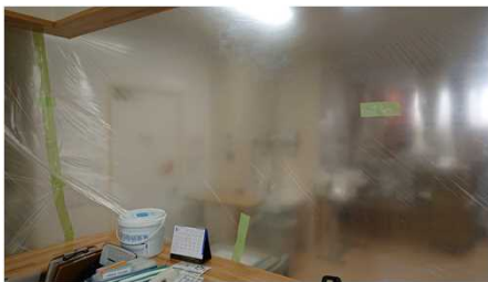
ビニールシートでの陰圧確認
