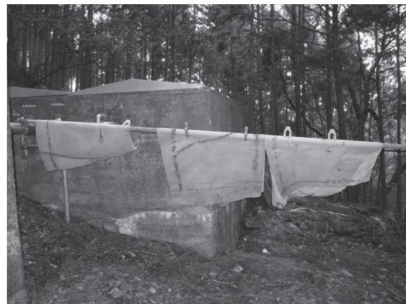
写真2 緩速ろ過池内に敷かれているろ過マット
