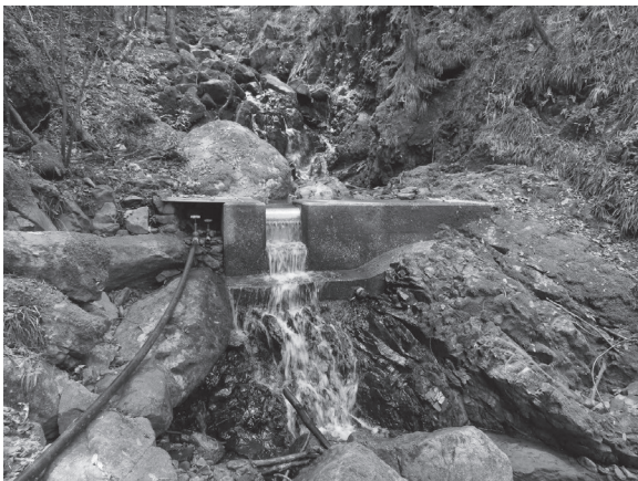
写真5 表流水取水柵（高知県大豊町津家地区）左手に導水管が見える。
