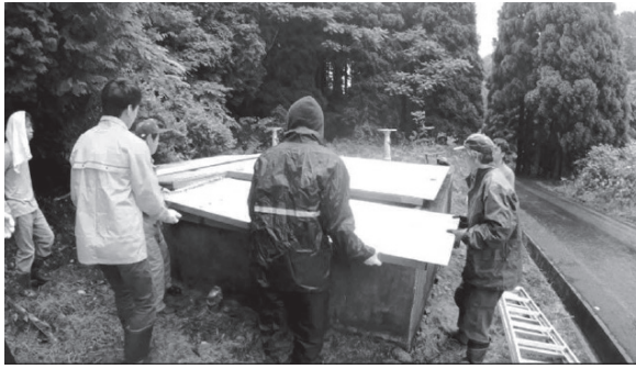
写真1 住民による浄水施設維持管理（清掃）の様子
