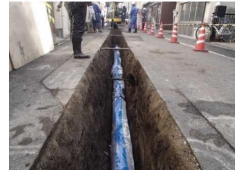
耐震管の布設イメージ
