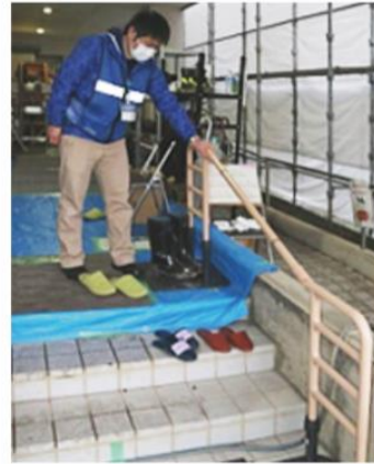
階段の手すり設置
