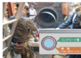
例：管路の耐震補強
