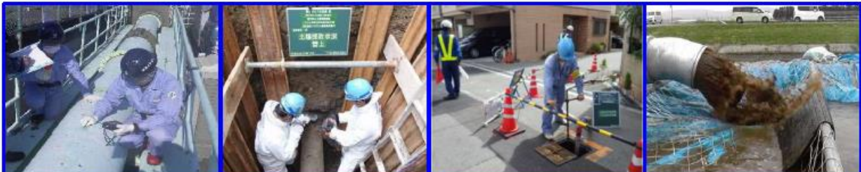
水管橋の点検
