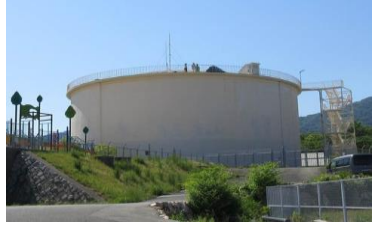
ー浄水池 (RC) 及びPCタンク ー下水道における沈殿池
