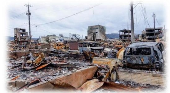
輪島市内の火災被害の状況
