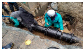
水道管復旧工事 (提供：横浜市水道局)
