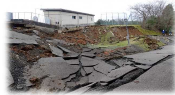
穴水町内の地割れ被害の状況
