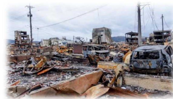
輪島市内の火災被害の状況
