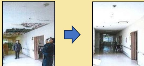
【介護施設の復旧の様子】
