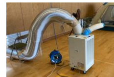
スポットクーラーの設置
