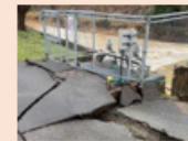
水道の復旧 (被災した浄水場)
